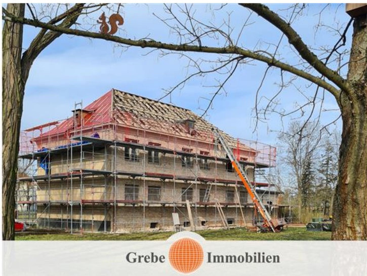
Fassadensanierung, Erneuerung der Dachziegel
